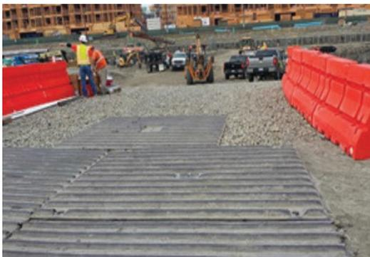
La entrada y salida del área de construcción está usando bardas y el tráfico que entra y sale se limita a un solo carril.
