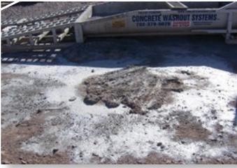
El desecho del cemento no debería de caer directamente en el suelo. Debería de ser depositado en un contenedor a prueba de fugas.
