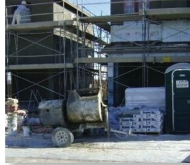
Un cobertor o lona plástica ha sido colocada debajo de la mezcladora para coleccionar cualquier material que pueda caer en el suelo.
