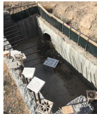
La barrera retenedora (wattle) o sacos de arena se han colocado a los lados y atrás de este drenaje de aguas pluviales.
