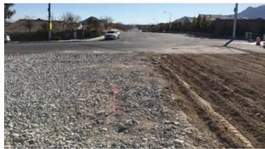
Establecer entradas/salidas al área de construcción para minimizar el transporte de tierra y barro hacia las calles. Entradas y salidas deben ser canalizadas con bardas para que el tráfico de vehículos que entran y salen de la construcción se limiten a un solo carril.
