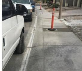
Material o polvo que desecha la sierra después de los cortes no debe quedar en el suelo o en la calle. Bolsas de arena se deben colocar alrededor del área para evitar ese problema.
