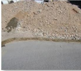
Barrera de retención (wattle) o bolsas de arena no están llenas o bien aseguradas para detener el derrame de material de construcción o desechos.
