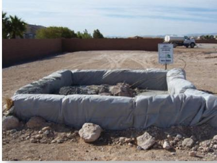
El contenedor que recibe el desecho del concreto está en buenas condiciones (no tiene huecos o grietas y no está goteando). No está tan lleno que se desborda y no hay regueros de concreto en el suelo alrededor.
