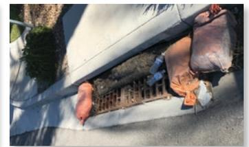
Las barreras retenedoras o sacos de arena no deben de estar dañados, rotos o abandonados al lado de los alcantarillados en áreas públicas. Deben de estar en buen estado y el sedimento y la basura que acumulan debe limpiarse regularmente.
